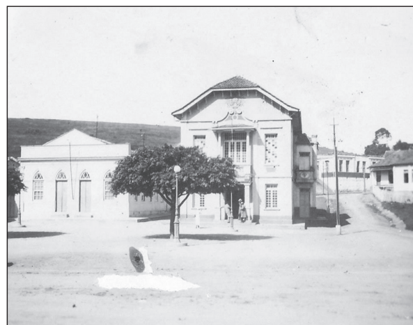
■ Antigo prédio da Prefeitura Municipal de Bicas
