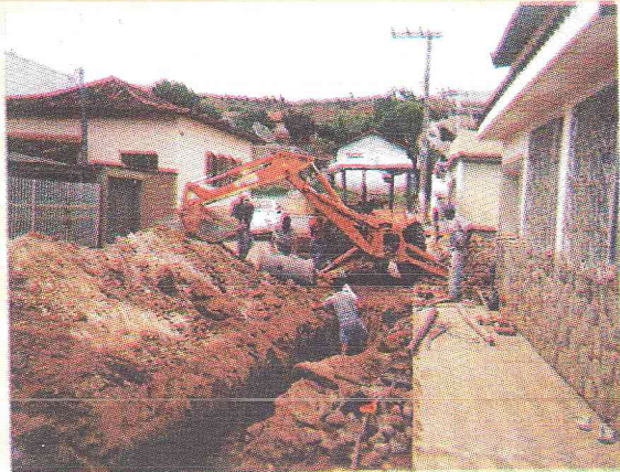
Colocação de manilhas na Travessa Pedro Dutra de Moraes, em continuidade ao projeto de saneamento básico desta Administração
