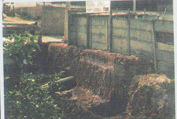
Início das Obras de Canalização do Córrego São José
