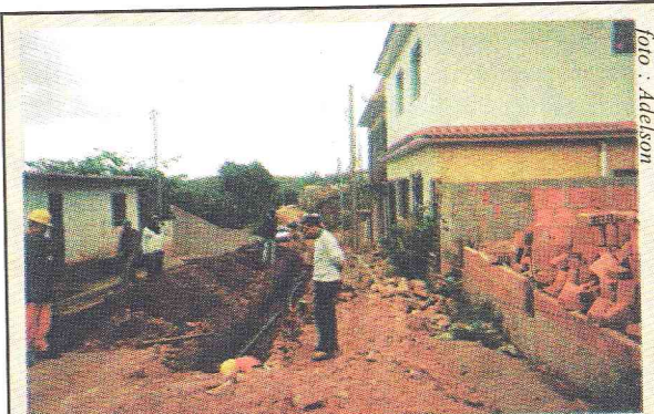
Colocação de Água e Rede de Esgoto no Bairro Sta. Terezinha - Morro do Cruzeiro
