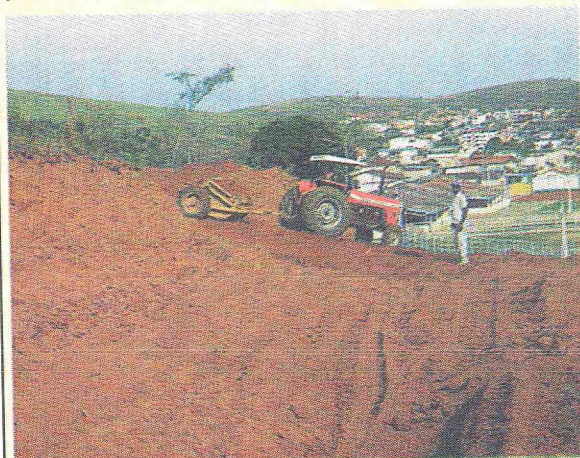
Serviços de terraplenagem no Parque de Exposição Francisco Retto Filho
