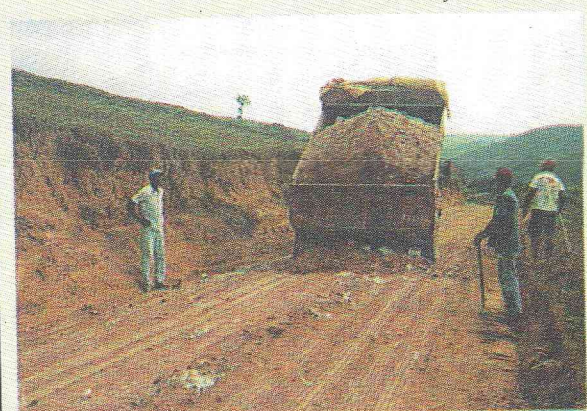
Patrolamento e ensaibramento de estradas rurais Captação de águas pluviais
