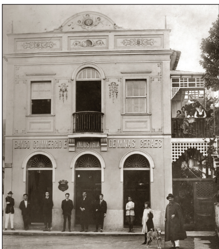
■ Prédio do Banco Comércio e Ind. de M. Gerais
